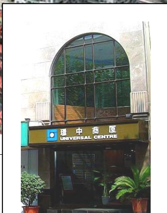
[ Entrée de l'immeuble ]
